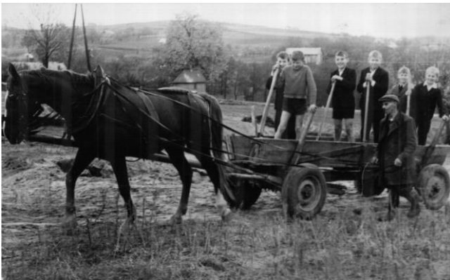
Rodzice i dzieci pomagają przy budowie szkoły.
