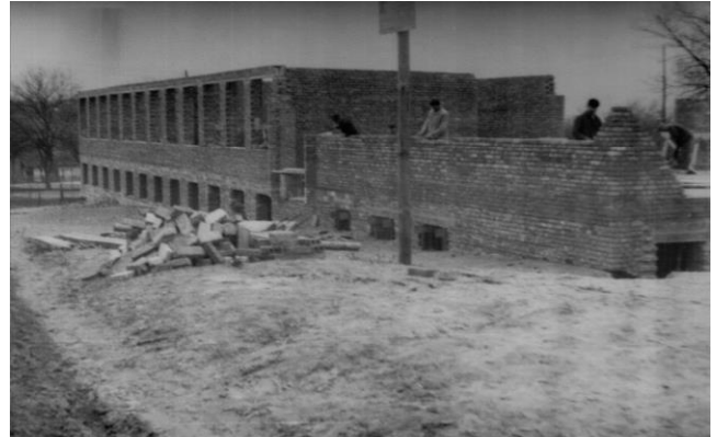
Budynek szkoły podczas budowy w 1965 roku.
